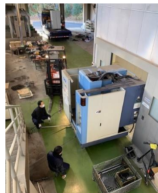
（写真は、マシニングセンターの撤去）
